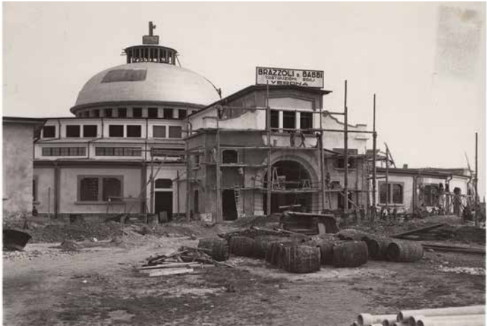
l’edificio durante le ultime fasi del cantiere (1930)
