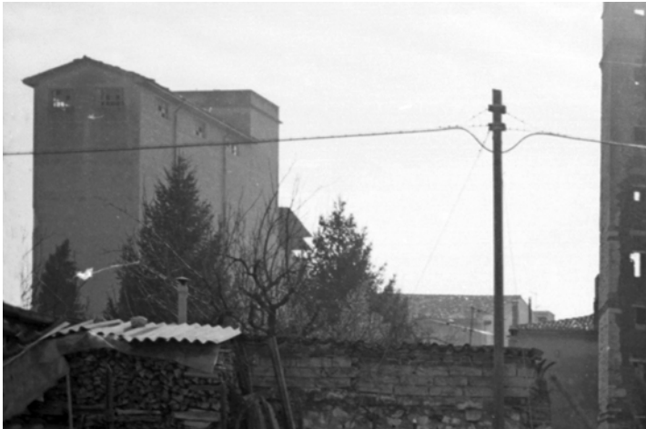
i silos del molino f.lli Zanetti (1987)
