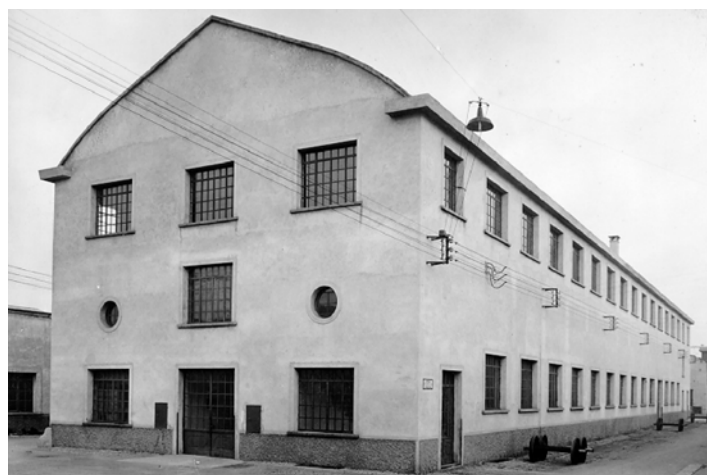
visione generale del fabbricato (1949)
