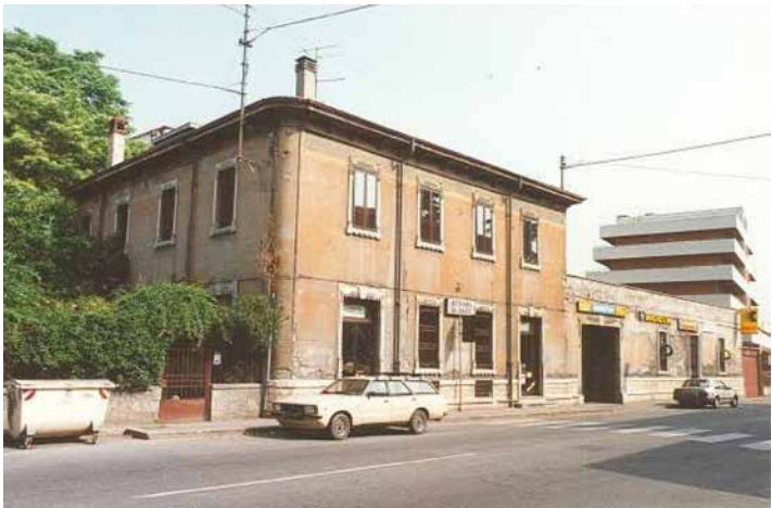
visione generale del fabbricato (1995)
