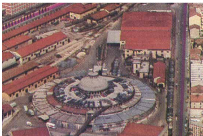
visione aerea dei Magazzini Generali (1975)
