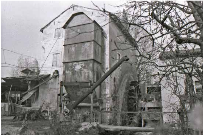
visione generale del fabbricato (1987)
