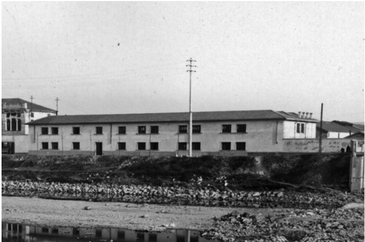
l'edificio dopo la ricostruzione (1949)
