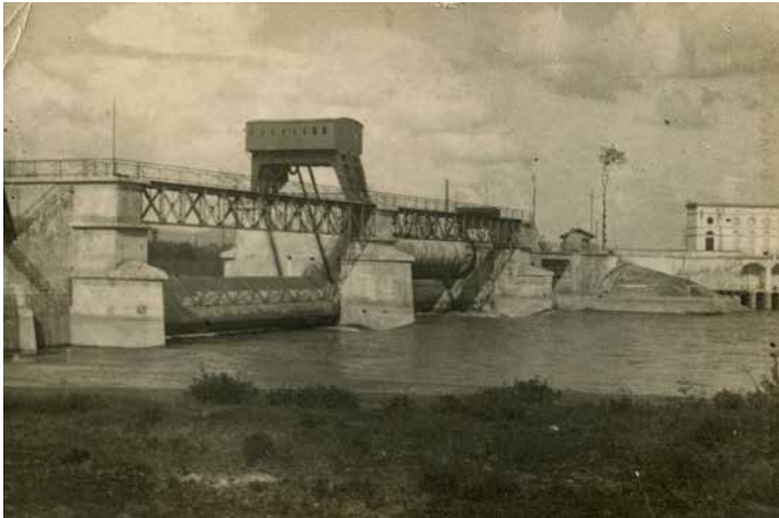
vista generale della diga (1925 ca.)
