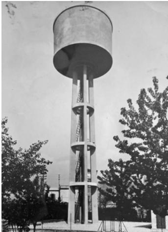
vista generale del serbatoio (1954)
