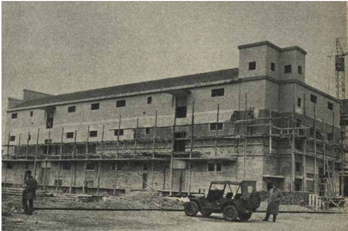
il fabbricato 26 durante il cantiere (1956)
