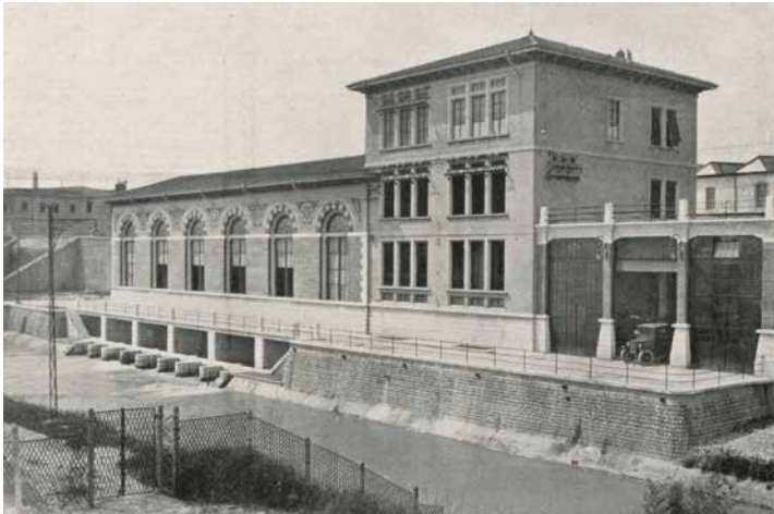
la centrale di Tombetta dopo la realizzazione (1923)
