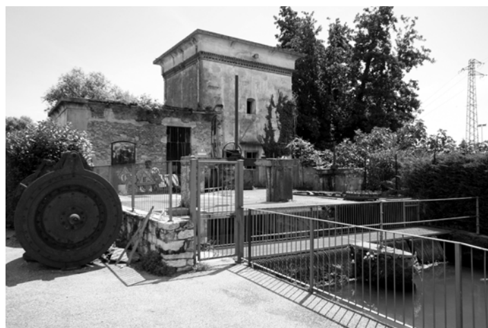
la centrale prima del recente restauro (2014)
