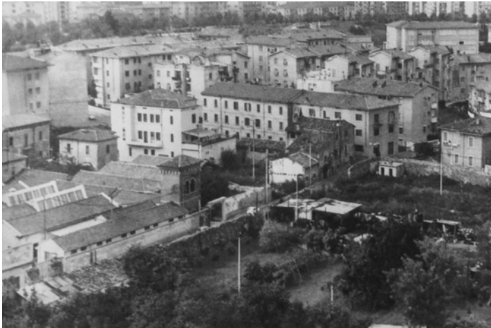
la cabina elettrica e il calzificio Recchia (1960 ca.)
