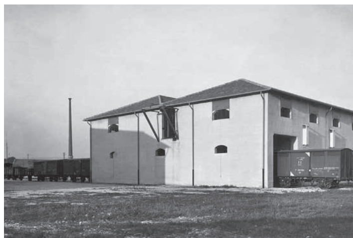
il primo nucleo del fabbricato (1927)
