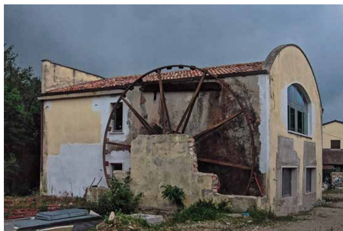
l'edificio prima del restauro (2006)
